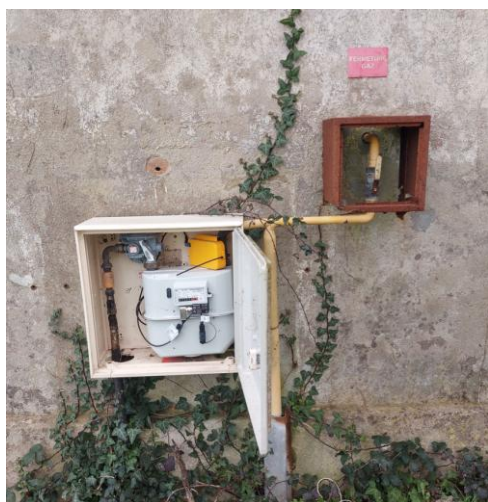
Coffret coupure/détente et compteur gaz en amont de l'atelier
