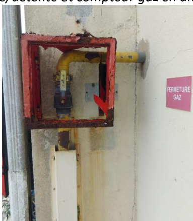
Coffret coupure gaz de la chaufferie atelier existante
