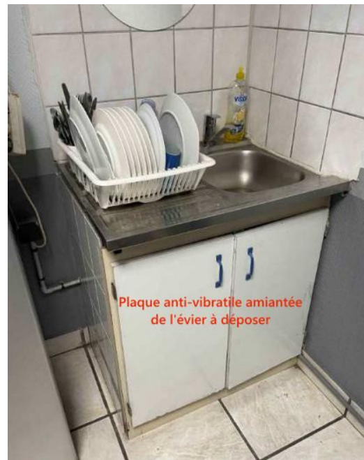
Salle de pause évier à déposer avec plaque anti-vibratile amiantée
