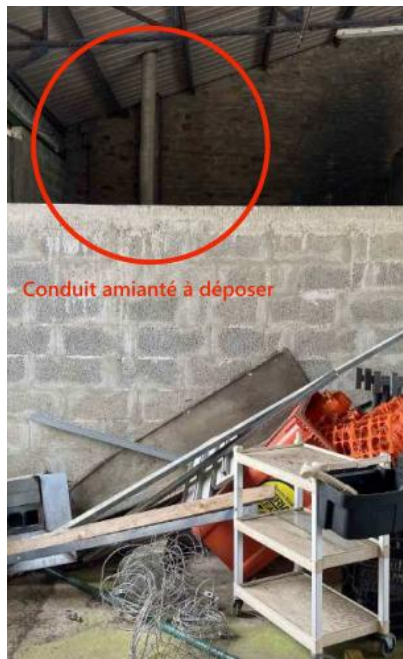
Conduit de fumée amiantée à déposer
